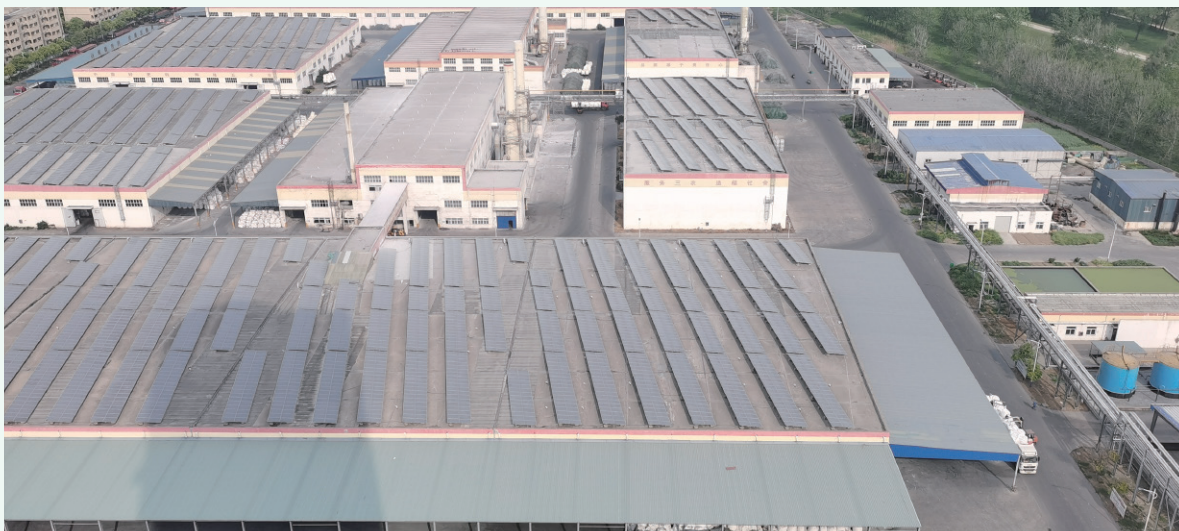
五禾生态光伏板建设
